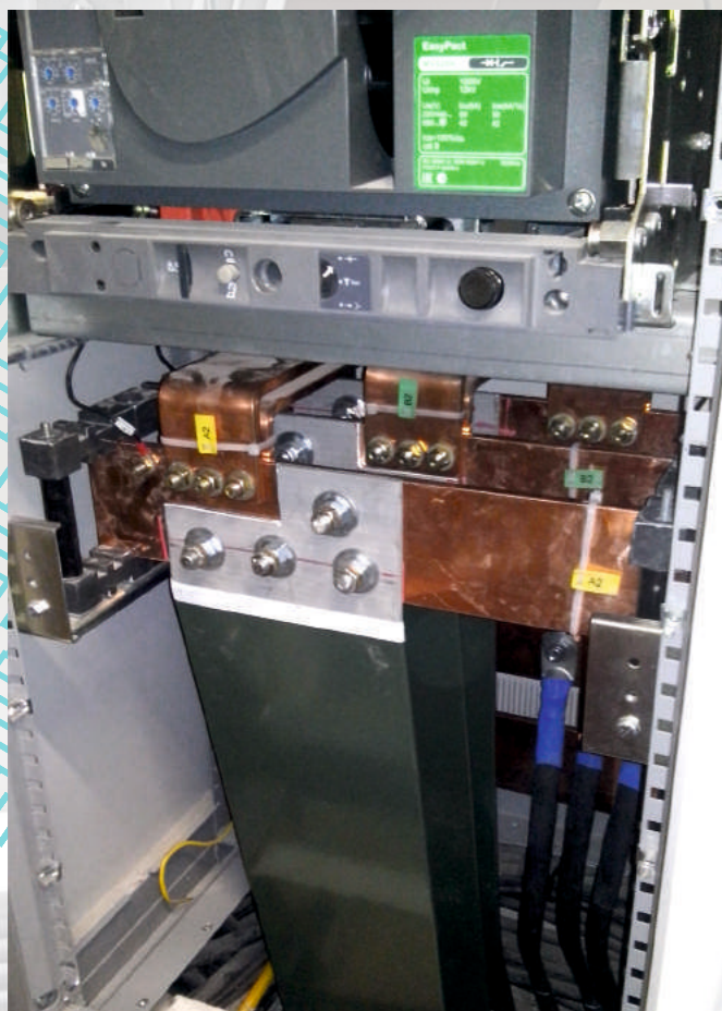
ПАО «Камаз», г. Набережные Челны Магистральные шинопроводы ЕЗ, 630А, 1000А, 2500А, IP55
