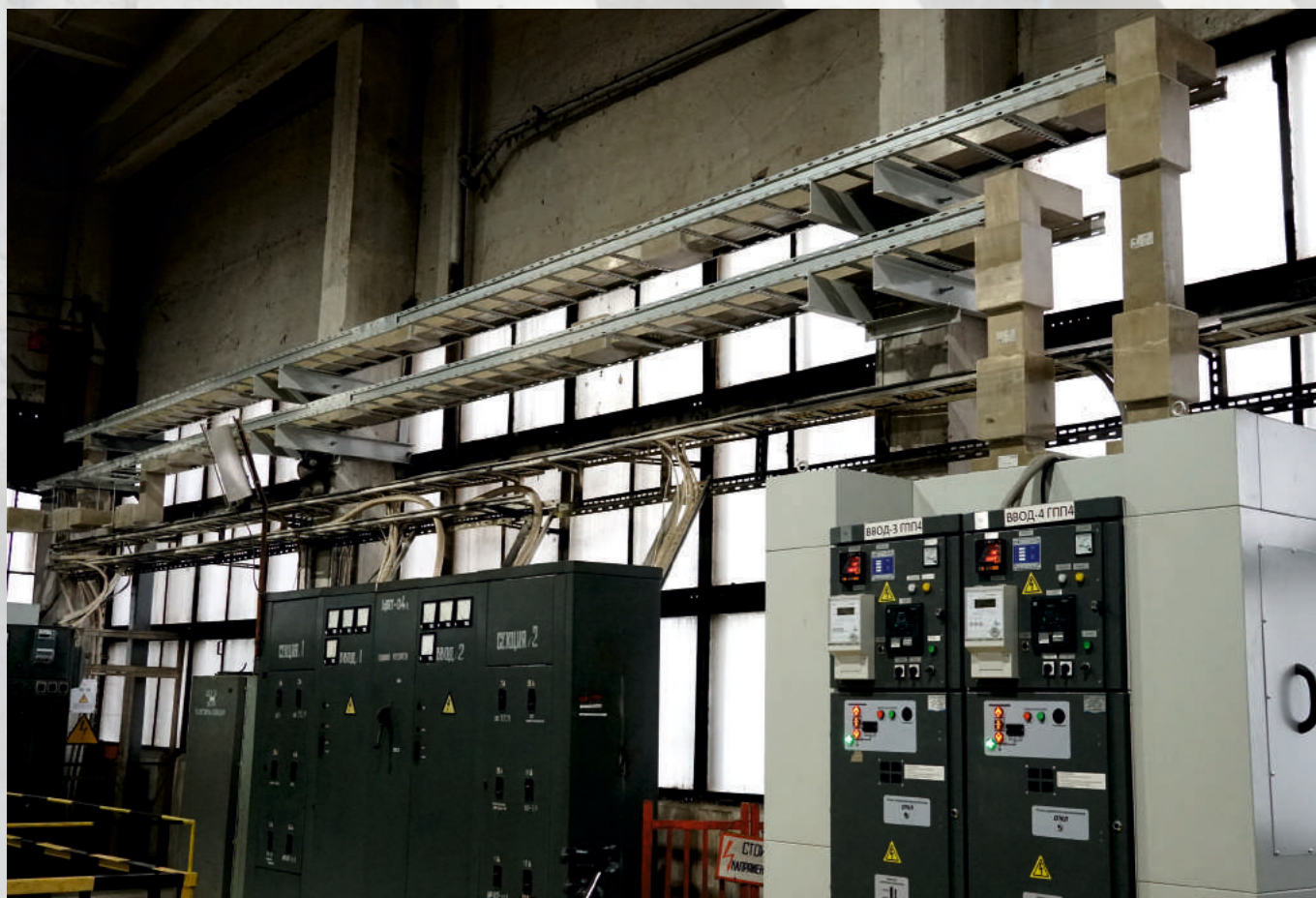
ОАО «ПНТЗ», г. Первоуральск Токопровод CRM, 1000А, 6 кВ, IP68
